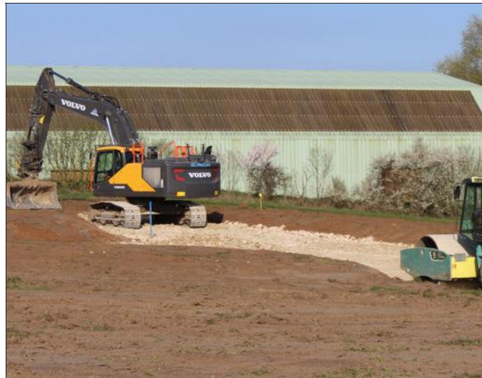
Les premiers coups de pelleuse ont été donnés afin de préparer la voirie provisoire de ce lotissement de 15 parcelles.
